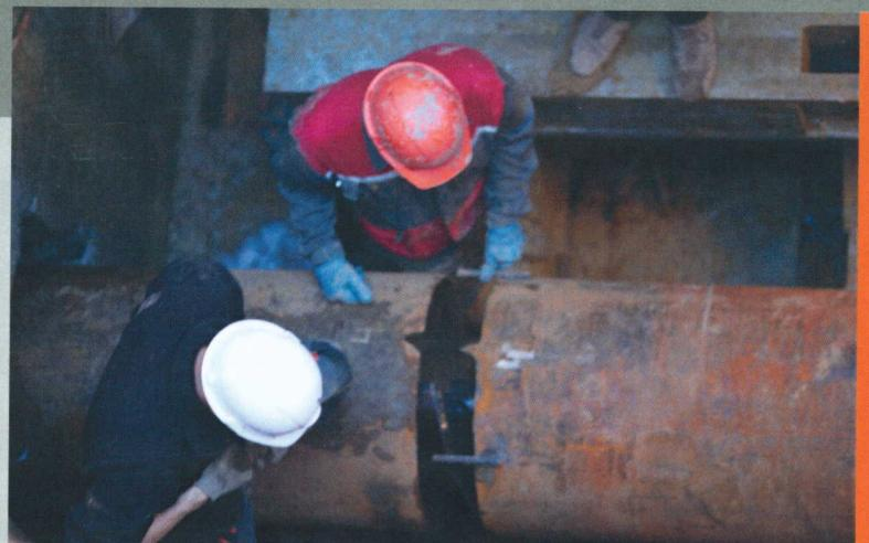
При подаче антифрикционной супензии в забойной зоне скважины происходит разжижение плотной глины. Это обстоятельство позволяет существенно снизить требуемые усилия машины при проталкивании колонны. Особенно при движении с вращением штанг. Другое важнейшее обстоятельство – в этом случае уменьшается износ штанг, бурового инструмента, но самое главное – снижается износ установки, следовательно, увеличивается срок ее безаварийной эксплуатации.
