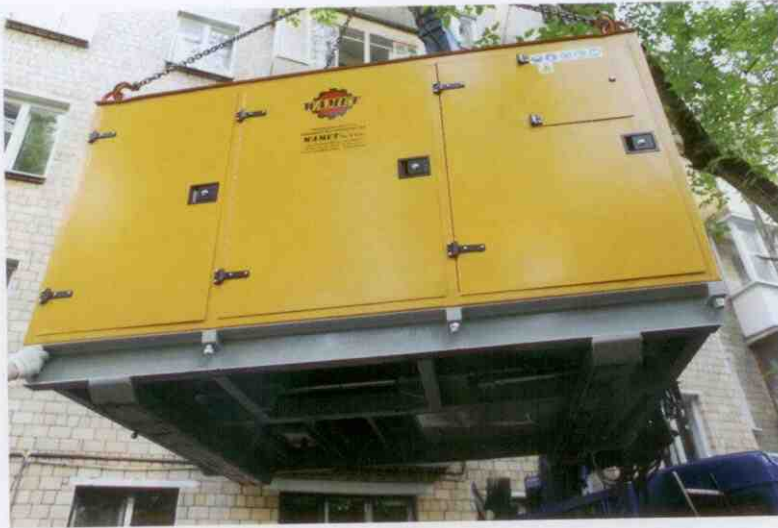
Разгрузка силового агрегата на объекте
