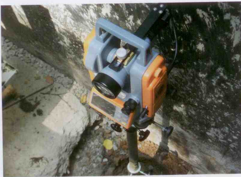
Лазерный теодолит в основании котлована
